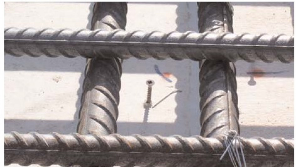
4. ruuvit asennettuna raudoituksen suojassa
